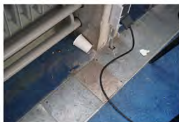
zeer zichtbare kabelgoot
