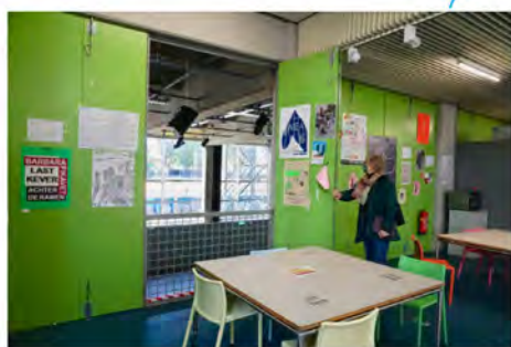
wandpanelen met bovenlichten vervangen door opendraaiende deuren
