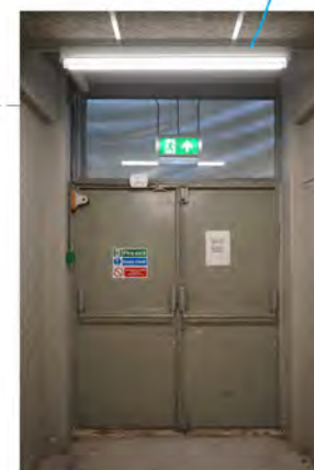
deuren naar trap naar buitenwerkplaats
