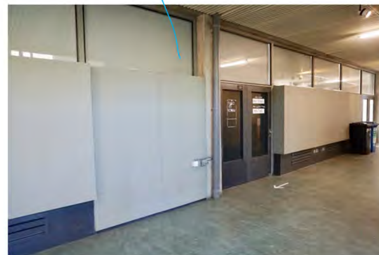
hier is gerommeld met de wand; de kleurvlakken zijn niet in orde. (origineel waren de doorlopende plinten een lichter grijs dan de deuren!); bovenramen geblindeerd.
