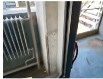
spoor van verwijderd aanrecht
