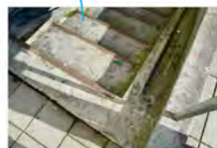
trap met stalen trapneuzen
