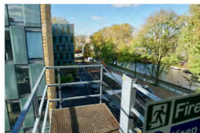
bovenste platform van de stalen buitentrap
