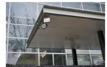
originele entree-luifel; ook plafond en lichtarmaturen origineel (luifel van buitenwerkplaats heeft hetzelfde randdetail)
