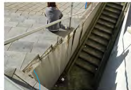
entreetrap opnieuw betegeld met zelfde materiaal.
