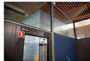
trappenhuis oorspr. in open verbinding met gevel
