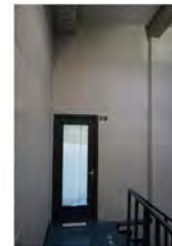
trappenhuis oorspr. in open ver- binding met gevel
