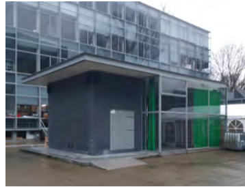
35. Later toegevoegde gevel beeldhouwpaviljoen, foto WDJ (2021)
