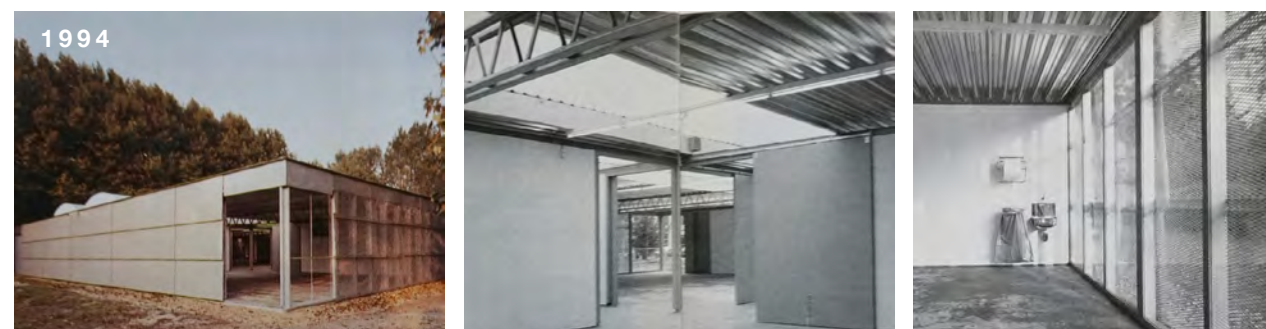
De noodbouw die in 1994 tot stand kwam (ontwerp Slothouber & Baart, foto's gepubliceerd in Bouw 17 juni 1994).
