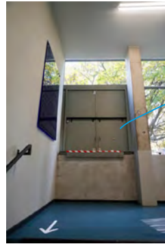
toegevoegde laaddeuren van trapbordes naar park singelzijde
