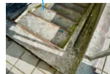
trap met stalen trapneuzen
