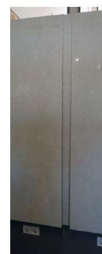
zogenaamde heldere details zijn niet altijd eenvoudig te reproduceren; e.e.a. zit snel een beetje ongelijk of scheef
