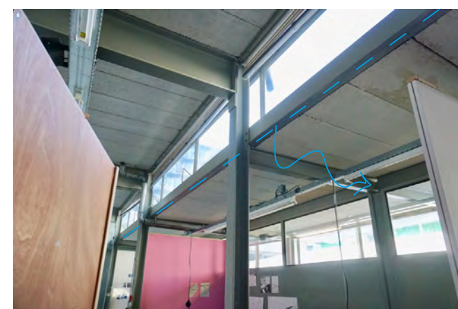
atelierzijde van de verplaatste gangscheidende wand; die stond oorspronkelijk tussen de kolommen, in hetzelfde vlak als deze bovenlichten
