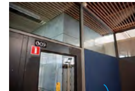
trappenhuis oorspr. in open verbinding met gevel
