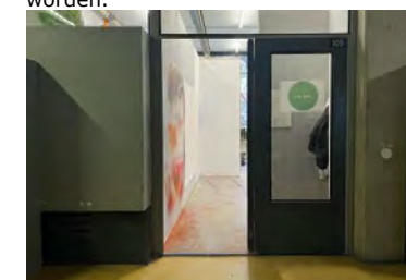
Fig. III.3.9: Schuur en schoonmaakmiddelen om verfresten te verwijderen zorgen voor kleur en glans verschillen in het linoleum.
