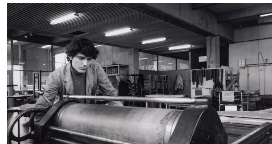
71. Verlichting toegepast in het ritme van de constructie, foto Doriann Kransberg (nov. 1997), Collectie Stadsarchief Amsterdam nr.010122004595
