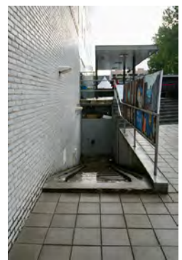
orig. pui volledig beglaasd; fietswielgeleiders nog op trap
