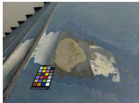
Fig. III.3.2: Slijtage van de gietvloer valt voornamelijk op doordat de witte vullingen die zichtbaar zijn geworden.
