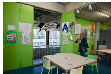
wandpanelen met bovenlichten vervangen door opendraaiende deuren
