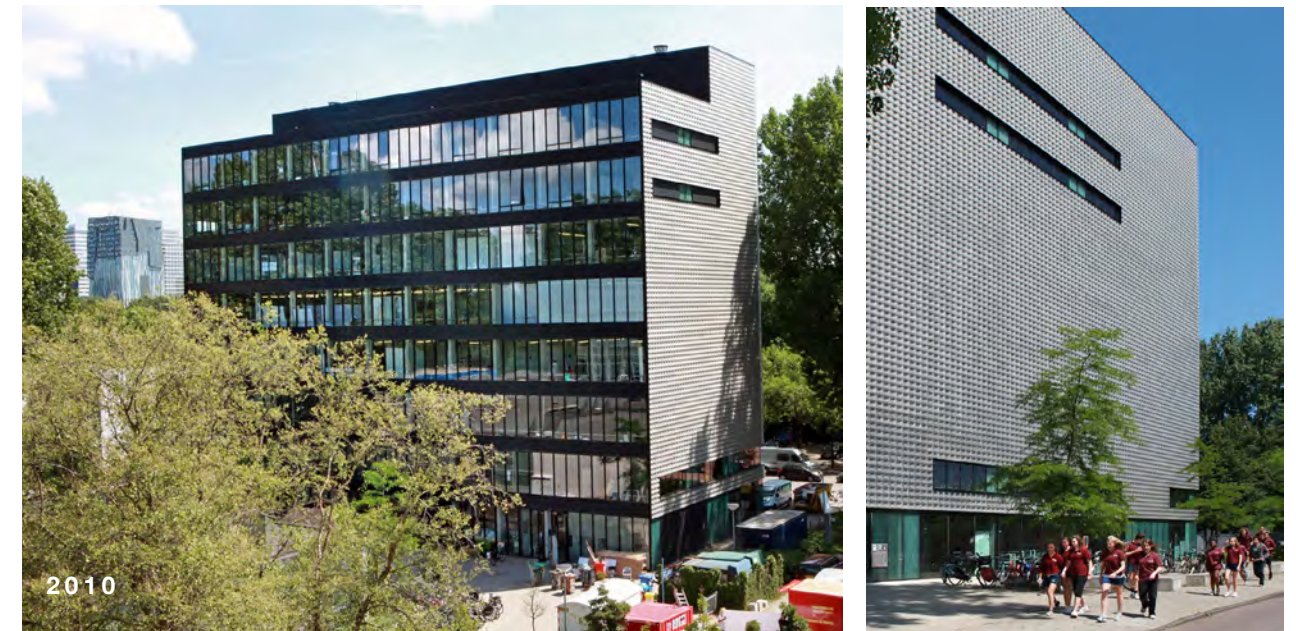
De uitbreiding van 2005, het Sandberg Instituut (ontwerp Benthem Crouwel architecten, foto's Doriann Kransberg, collectie Stadsarchief A'dam, nrs. D10134003042 (rechts) en D10134003393(links))
