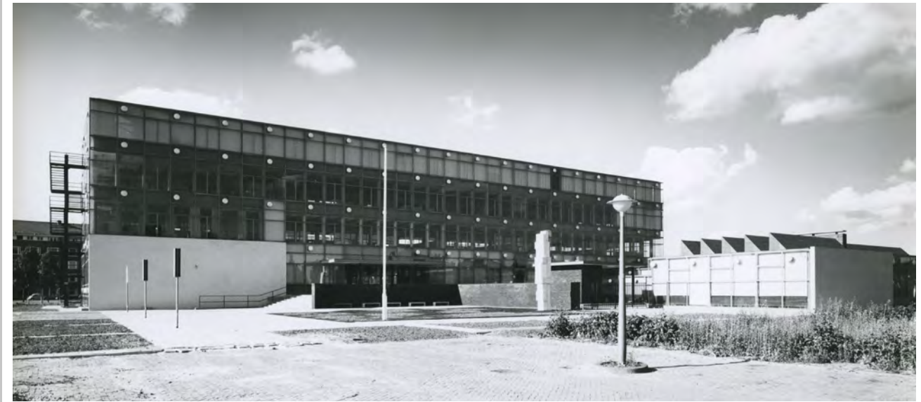
38. Oorspronkelijke gevelventilatoren in de vliesgevel, foto Ton Roelofsma (1967)
