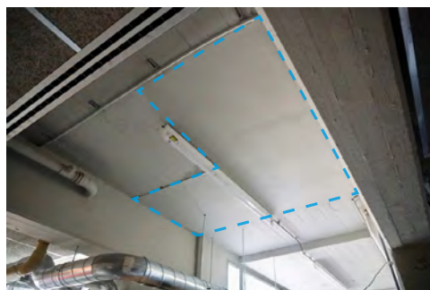
het gat ter plaatse van de voormalige wenteltrap vanuit de entreebalie-ruimte is dichtgemaakt
