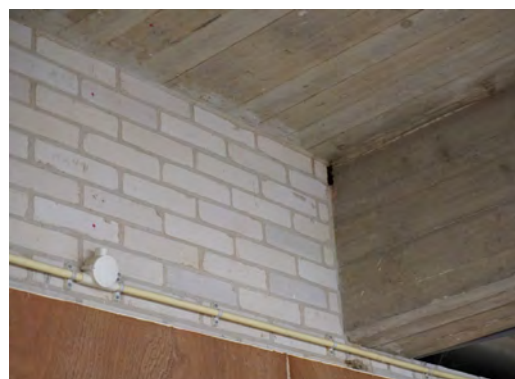
origineel kalkzandsteenmetselwerk in witte schakeringen met lichte voegen; onderkant van de houten vloer; betonbalk met afdruk bekisting
