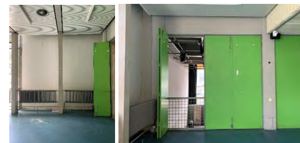
gestucte wanden : lichtgrijs te schilderen_nieuwe flexibele panelen : middengrijs te schilderen
