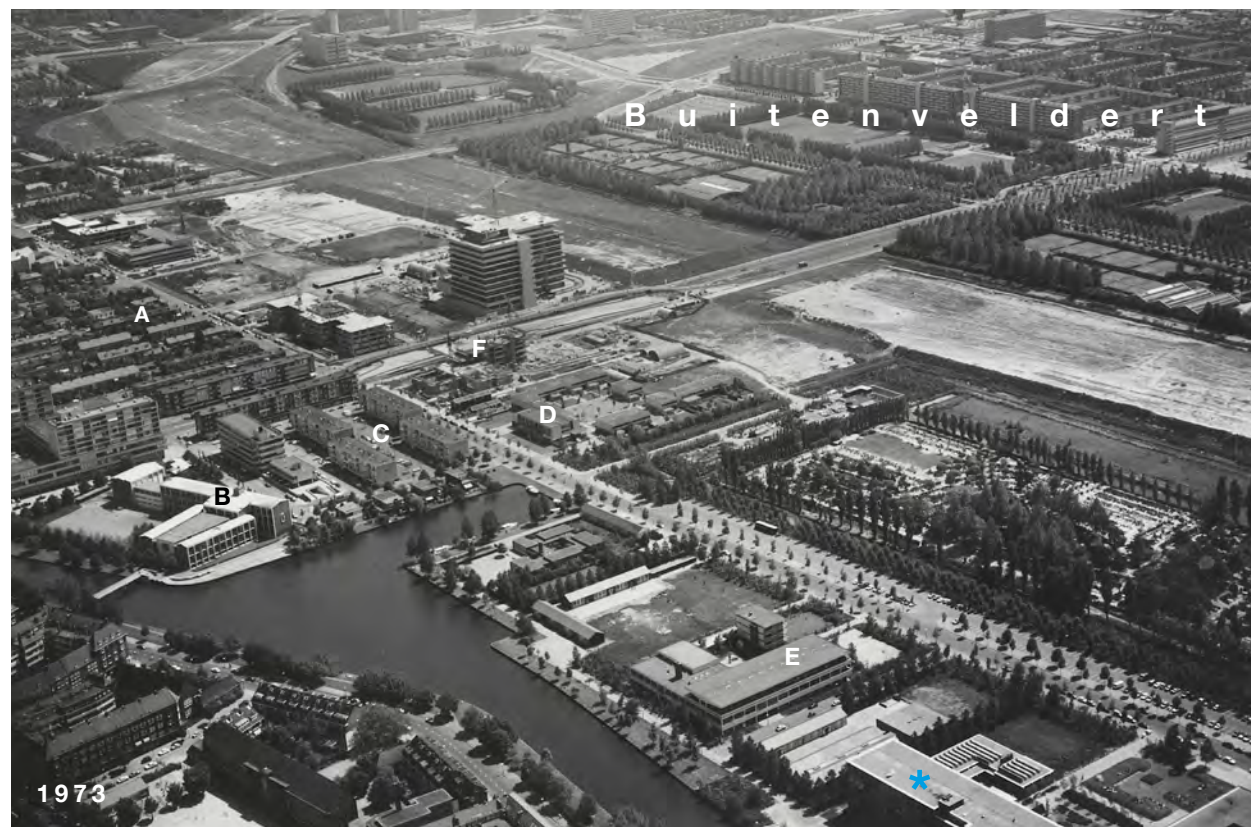
Bijna de hele Prinses Irenestraat (zoals de Fred. Roeskestraat tot 1977 heette) t.t.v. de bouw van 'De Parnas' (foto: Dienst Ruimtelijke Ordening, coll. Stadsarchief Amsterdam, nr. B00000034426).
