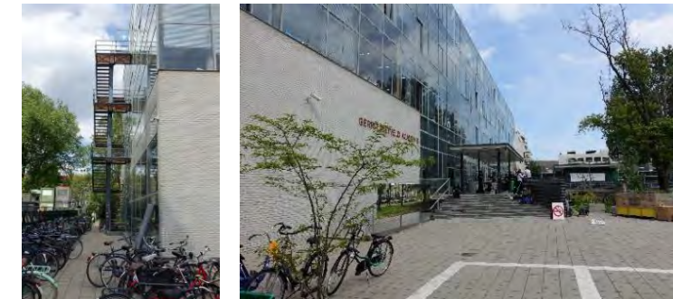
westgevel met noodtrap, voorgevel (zuid) met entree bordes en luifel, 2022
