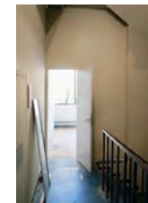
trappenhuis oorspr. in open verbinding met gevel
