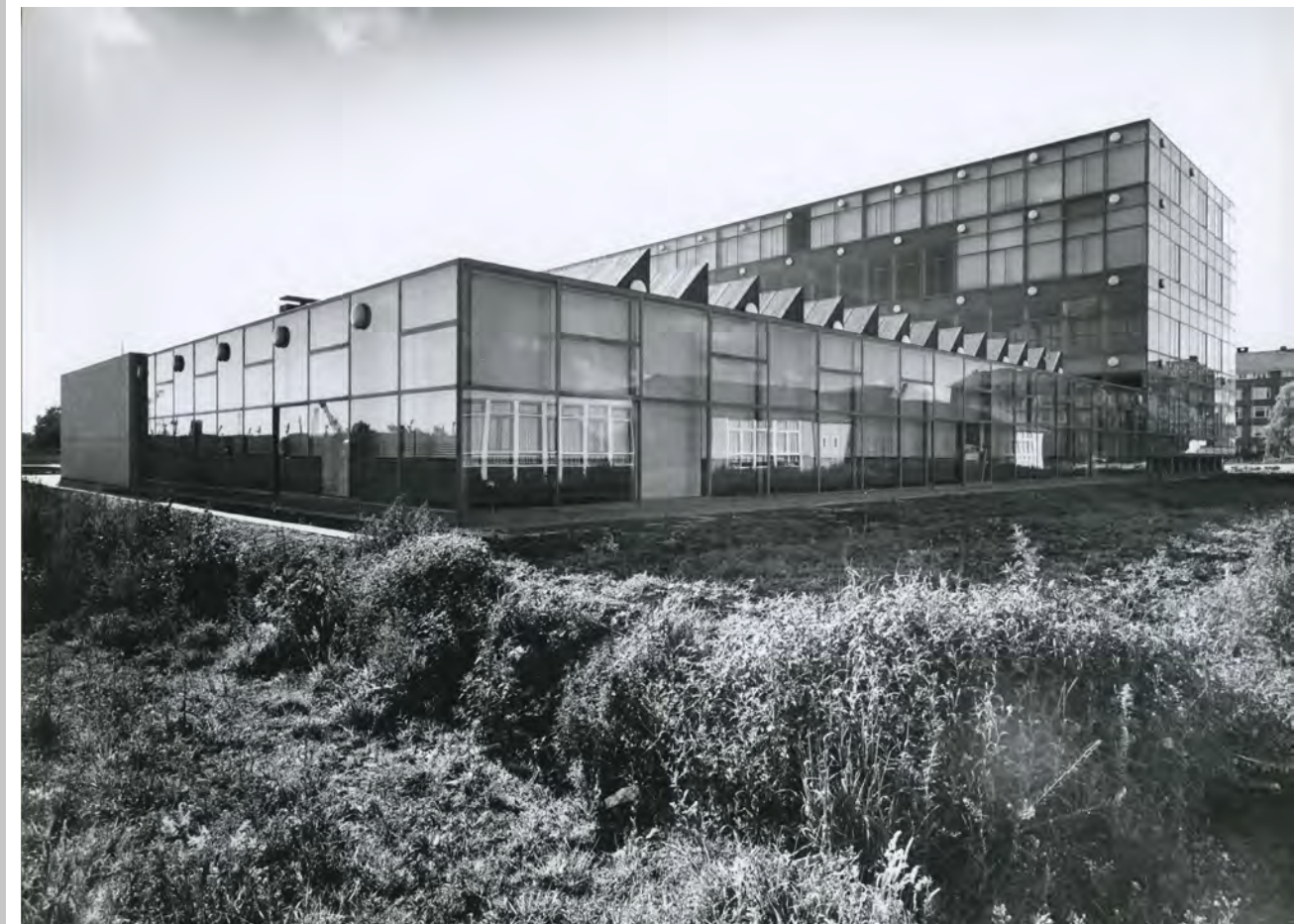
61. Werkplaatsen in 1967, foto Ton Roelofsma, 1967
