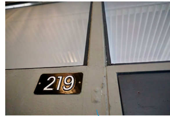
ter plaatse van de deur een breder kokerprofiel
