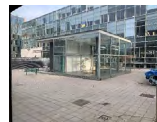
werkplaats met trafohuisje, 2022
