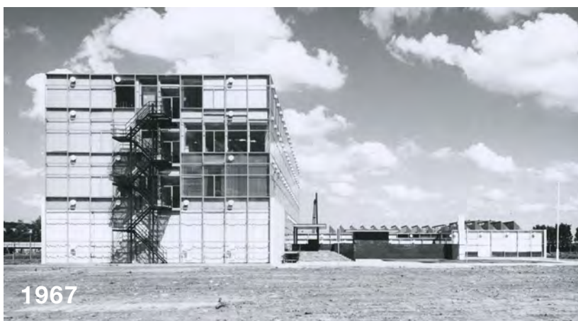
in het oorspronkelijke beeld gaven de sheddaken van de laagbouw een industriële uitstraling; de stalen trap lijkt hier veel donkerder dan hij nu is (foto Ton Roelofsma nr. 67-447-1)
