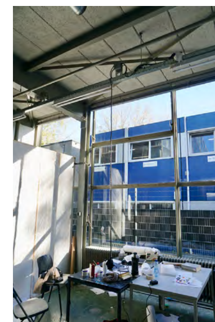
de werkplaatsvleugel is uitgevoerd in een laagbouw in staalconstructie, met veel licht door sheddaken. vliesgevel en ruimtescheidende wanden hier hetzelfde als in de hoogbouw. nieuwe kalkzandsteenwanden herkenbaar aan egaal gekleurde steen en contrasterende donkere voegen
