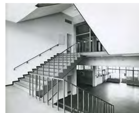
Fig. III.1.11: Kunstharvloer (Plasnalo) in het trappenhuis. Foto: Ton Roelofsma, 1967.
