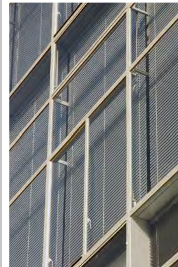
33. Vliesgevel met te openen ramen, foto Hans Vroeghe (2004)
