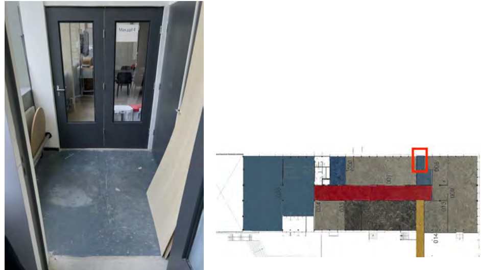
Fig. III.2.9: Op de begane grond bevindt zich een ruimte met de originele Plasnalo vloer. Deze ruimte ligt tussen ruimte 105 en 107 en was origineel onderdeel van het noodtrappenhuis. Ook in de ruimte meer naar het trappenhuis ligt de originele Plasnalo vloer.
