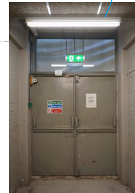
deuren naar trap naar buitenwerkplaats
