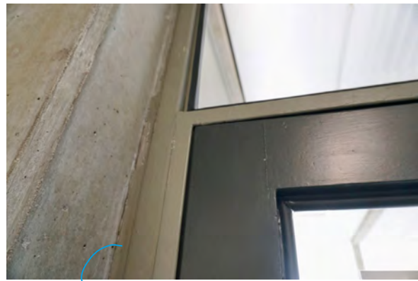
de rand van de houten lat tegen het beton is onopvallend meegeschilderd in staalkleur
