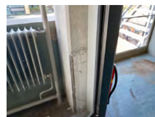
spoor van verwijderd aanrecht
