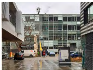
7. Huidige benadering v/h gebouw, foto WDJJA
