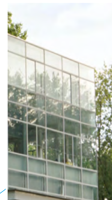
klimaatinstallatieruimte op een plek die in de oorspronkelijke plattgrond een grote open ruimte was.
