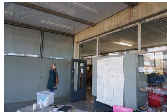
de horizontale vlakverdeling van de wanden is op deurhoogte; de hoogte van de ramen erboven is afhankelijk van de beschikbare ruimte; onder de betonnen liggers naar de gang is minder hoogte
